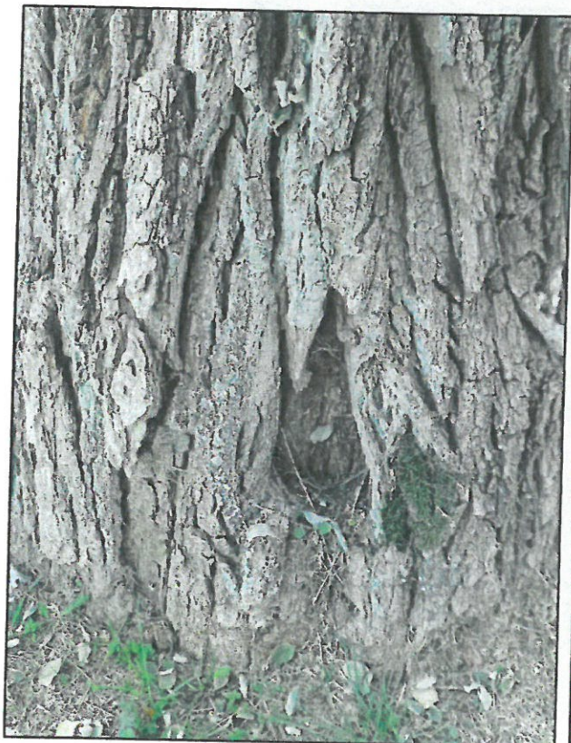
Zdj. 7. Ubytek z wypróchnieniem w odziomku
